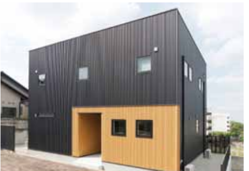
外壁は黒のガルバリウムを採用。窓選びにもこだわってスライド式の窓ではなく、正方形を選ぶことでさらに統一感のある仕上がりに。
